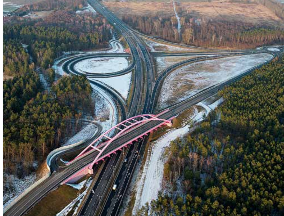
Construcción de una segunda plataforma en la circunvalación de Międzyrzecz, autopista S3 (km 0+000,00 – km 6+370,00) / Polonia
