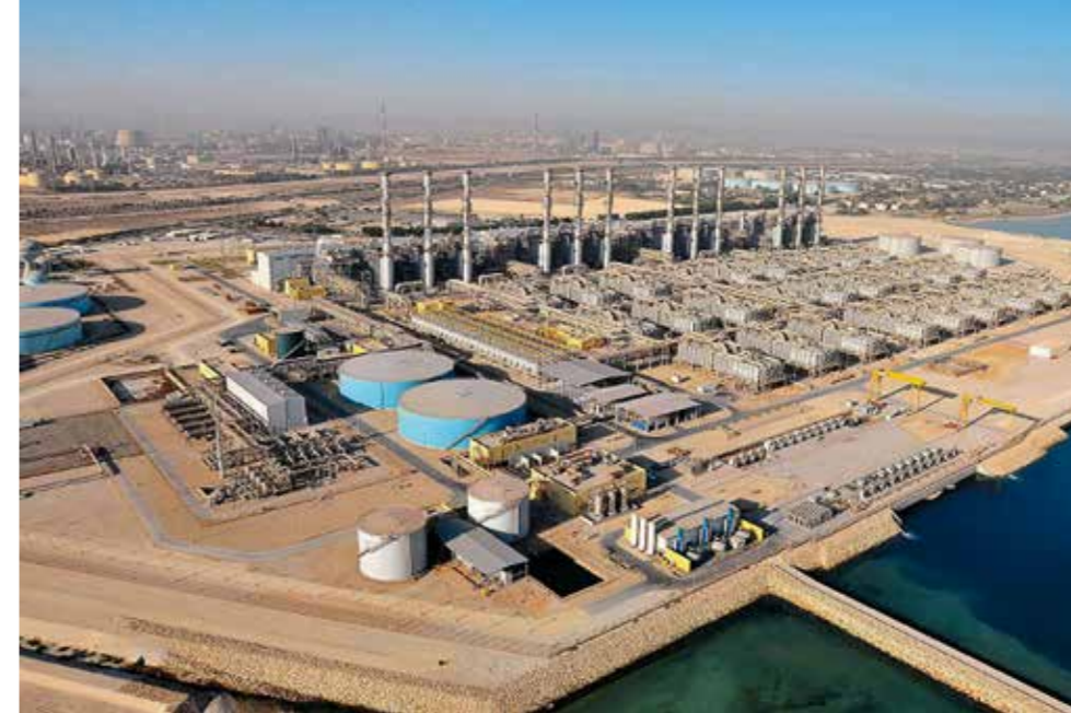
Planta desalinizadora de Mamelles – Dakar / Senegal
